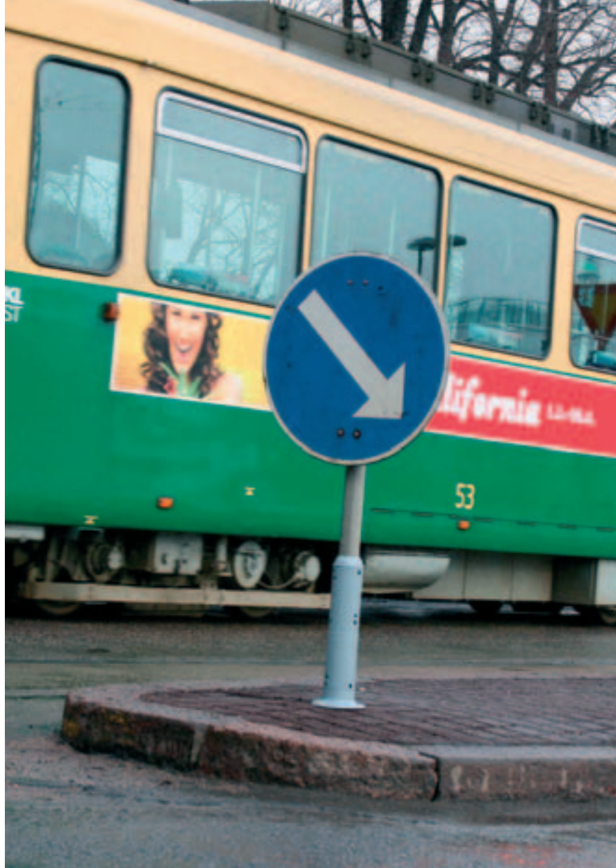
Liikennemerkin juurisuojaus paikoilleen asennettuna.
